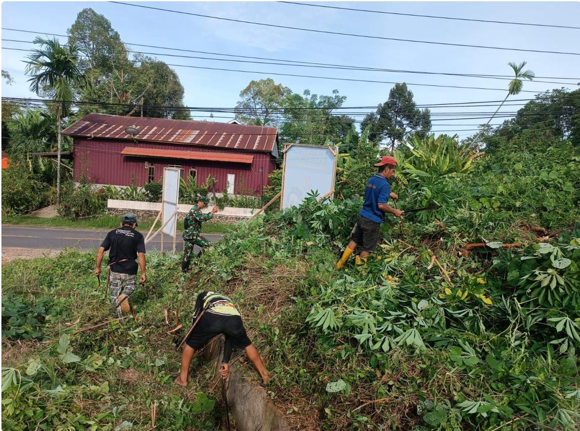
Kegiatan ini dilakukan untuk membersihkan parit dari material sampah dan rerumputan yang menyumbat aliran air. Material sampah yang menumpuk di saluran drainase dapat menyebabkan tersumbatnya aliran air, berpotensi menciptakan genangan air, dan menjadi sarang penyakit. Oleh karena itu, pembersihan secara rutin sangat penting untuk mencegah dampak negatif tersebut.
