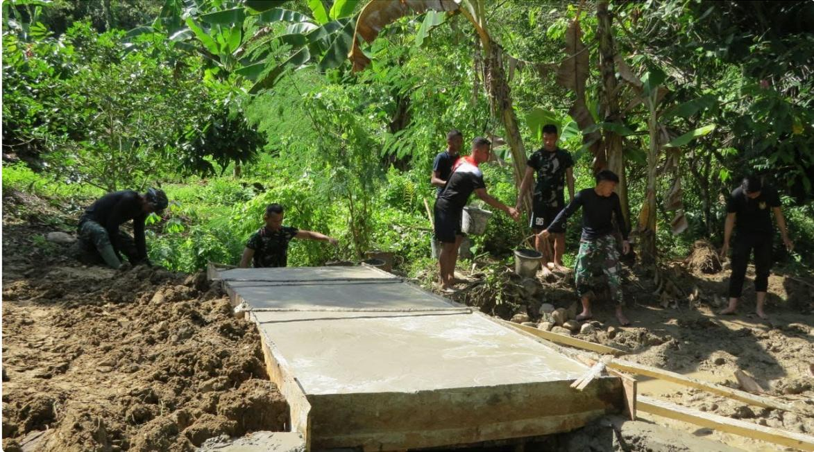
Plat duiker ini berfungsi sebagai saluran air yang membantu mencegah genangan air di jalan, memastikan kelancaran drainase dan memperkuat struktur jalan.
